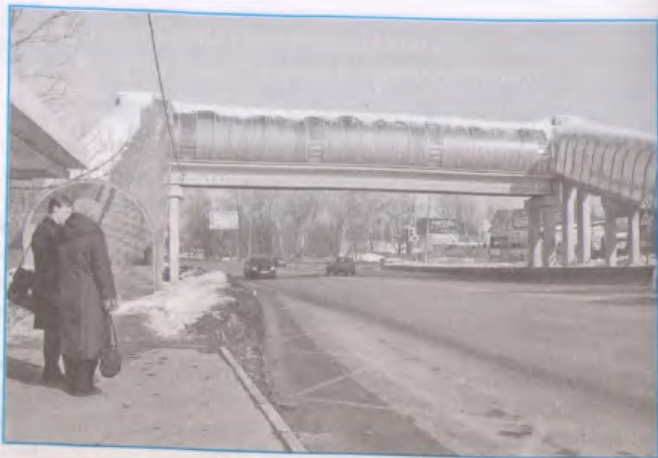
Надземный переход через Щёлковское шоссе. Город Балашиха. Московская область
