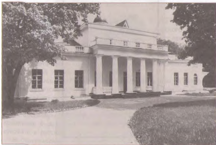
Овстуг. Фасад усадебного дома
