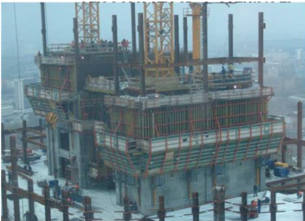
Рисунок 3.18 – Самоподъемная опалубка при строительстве небоскреба в г. Москва, 2008 г.
