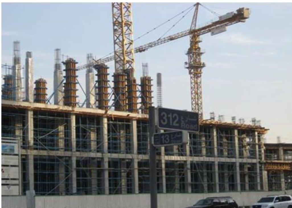
Рисунок 3.2 - Возведение здания высотой 20 этажей с применением традиционных опалубочных систем (г. Дубай, 2008 г.)
